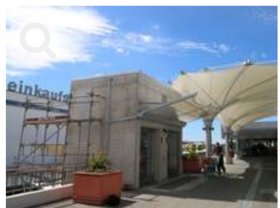
Die Passage zwischen Parkdeck und Aufzug wurde überdacht. Foto: Rüdiger Busch
